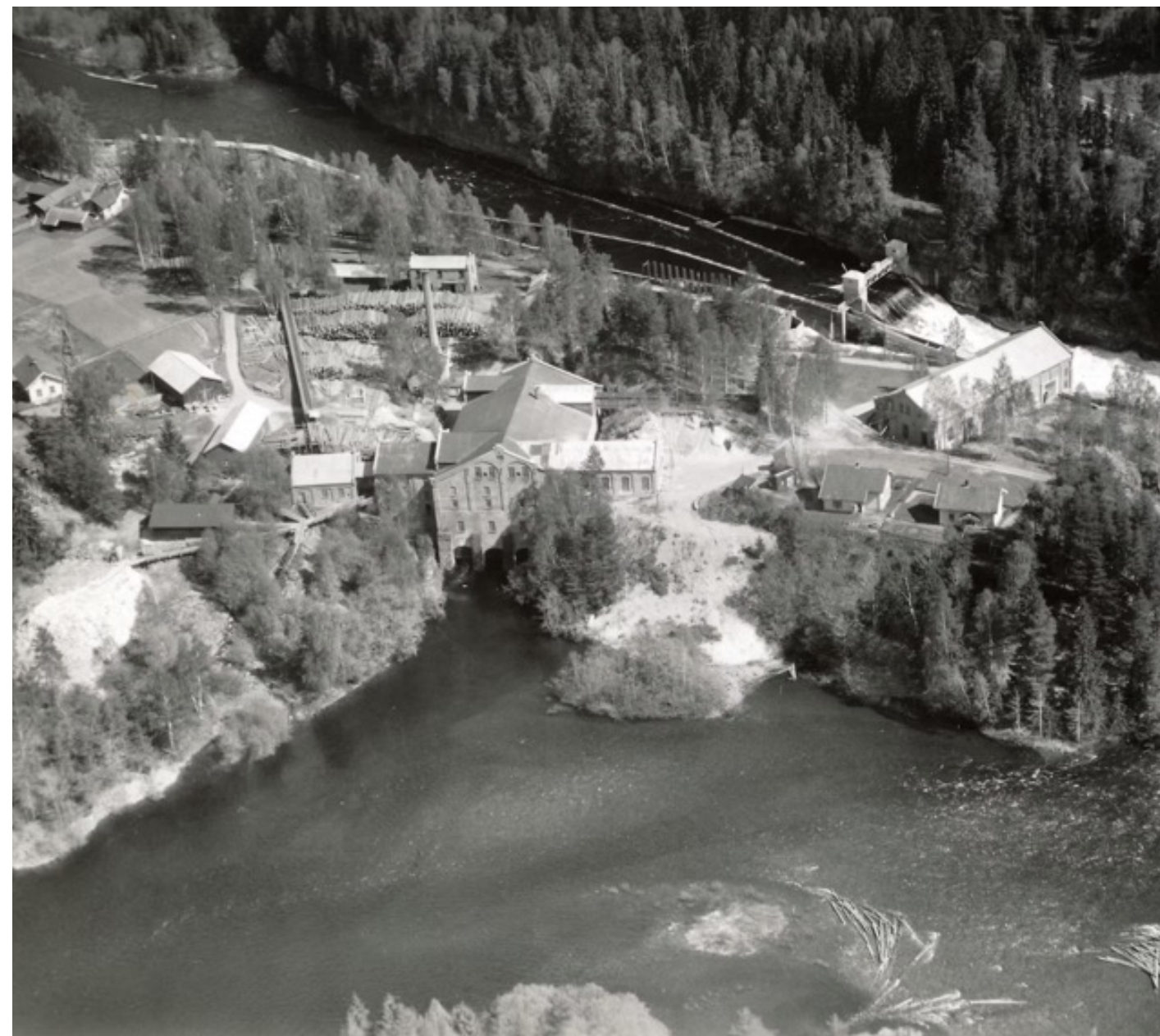
Oversiktsbilde over A/S Kistefos Træsliberi ca. 1950–55. Bilde viser den gamle broen før nåværende restaurering i 2023.
